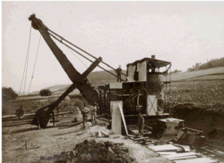
Bild 103: 9. August 1910 „Bagger“ oder besser: Die dampfgetriebene „Erdabhebmaschine“ beim Bahnhof Hardheim
