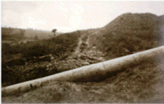
Bild 79: 13. August 1910 Rohrdolent bei 78 +75; in der Mitte unterspült
