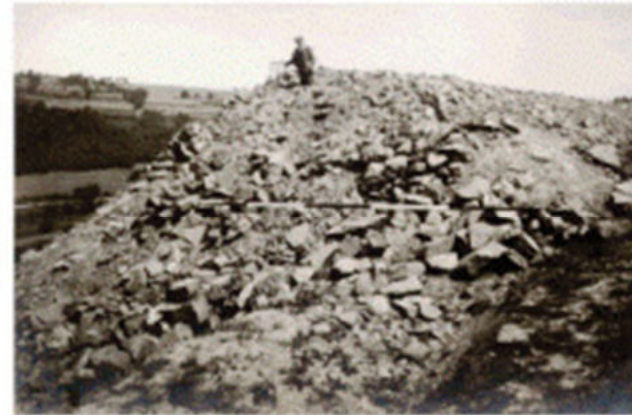
Bild 80: 13. August 1910 Gute Steine im geschütteten Damm
