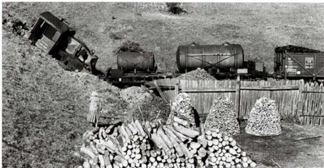
Mitte der 50er Jahre war in Hardheim aufgrund des starken Güterverkehrsaufkommens eine Kleinlokom stationiert. Im Juni 1957 überfuhr Köf II 6250 (die spätere 323 558) des Bw Mannheim einen Preßbock und landete im nachfolgenden Wiesenthang. AUSNAHME: FOTOSTILLER BERNHARD, HARDHEIM
