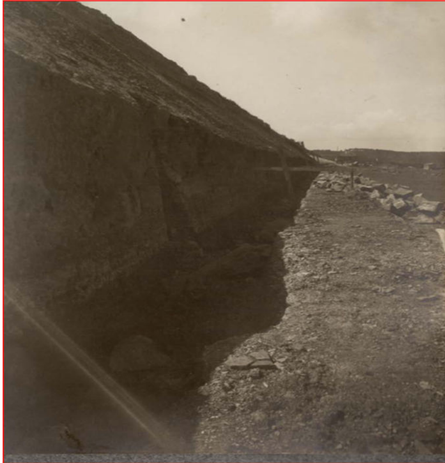
Hangsicherungsarbeiten in Höpfingen
