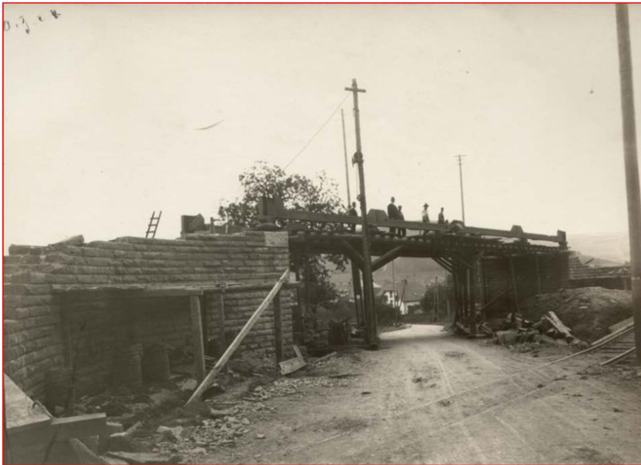
B 27; Die Bahnbrücke in Hardheim Nr. 94 fehlt
