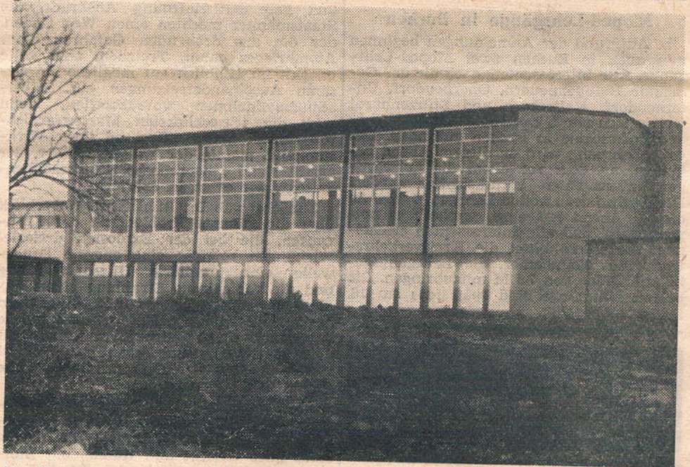
Hardheim. Die neue Turnhalle in Hardheim.
